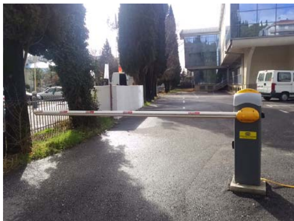
Slika 7. Ulazna rampa parkinga kontrolisana opisanim GSM sistemom.
