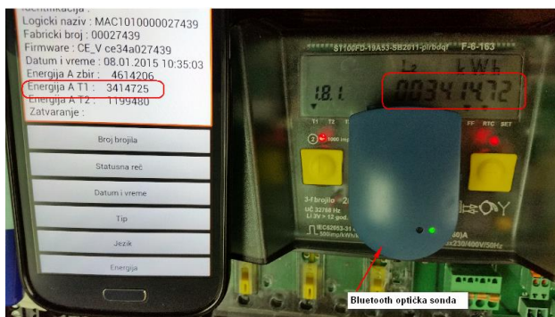
Slika 10. Očitavanje podataka iz RUDNAP brojila preko bluetooth optičke sonde
