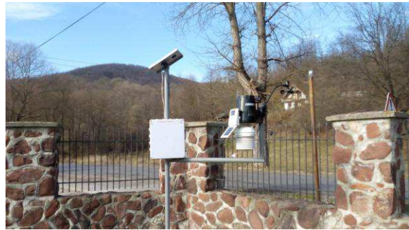
Slika 6. Lokacija za prikupljanje i distribuciju podataka merenja kiše i ostalih meteoroloških parametara i automatsko alarmiranje u skladu sa definisanim kriterijumom na slivu reke Crnice
