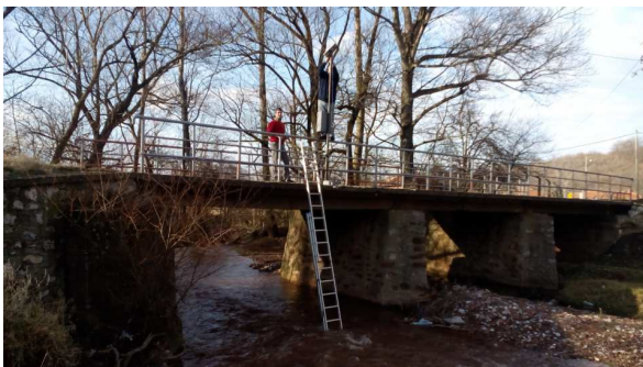
Slika 5. Lokacija za prikupljanje i distribuciju podataka merenja nivoa vode i automatsko alarmiranje u skladu sa definisanim kriterijumom na reci Grzi
